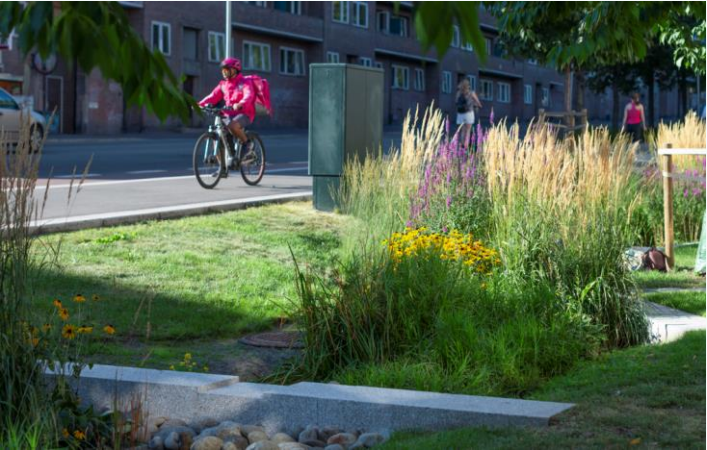
Raingarden in Maridalsveien (Photo: Oda Fjellang)
