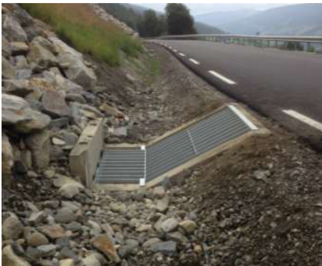
Figur 9.19 Selvrensende stikkrenneinntak. (Foto: NVE)
