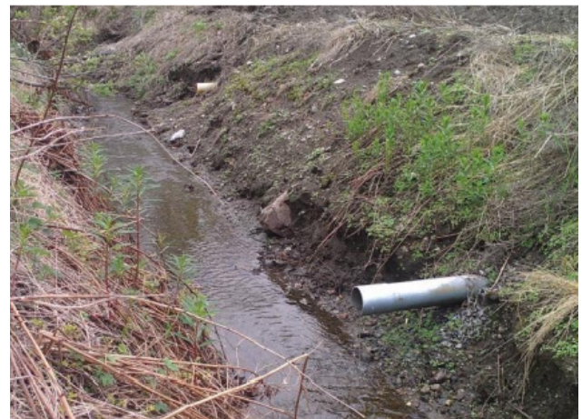
Figur 9.16 Eksempler på usikret utløp fra rør i sidehelling til bekker/elver, hvor det har erodert under utløpspunkt. (Foto: Torgeir Tajet, Norsk Landbruksrådgiving)
