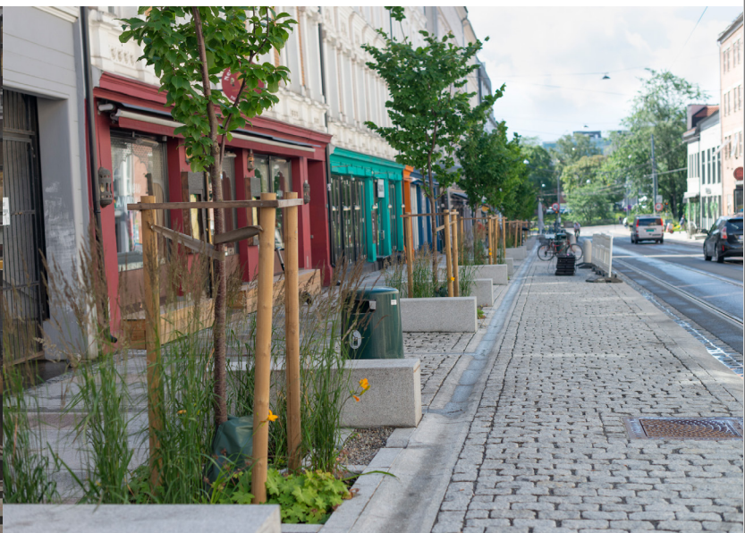
Figur 5.4 Regnbed og trær i Thorvald Meyers gate i Oslo. (Foto: Oda Balke Fjellang)
