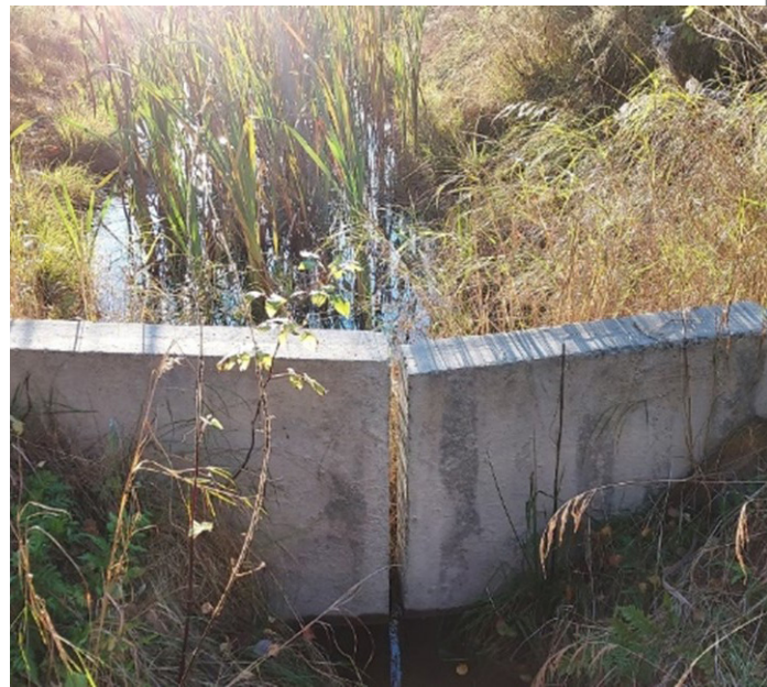
Figur 15 Terskel (utløpskant) med slisse slik at magasinet oppstrøms kan tømmes og gi plass for nytt vann ved nedbør. Merk at terskelen er lavest på midten, slik av vannstrømmen ikke graver i sidekantene. (Foto: Asplan Viak)
