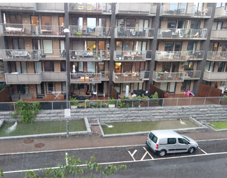
Takvann ledes ut på terreng fra innvendig taknedløp. Foto: Jakob Myking, Rambøll
