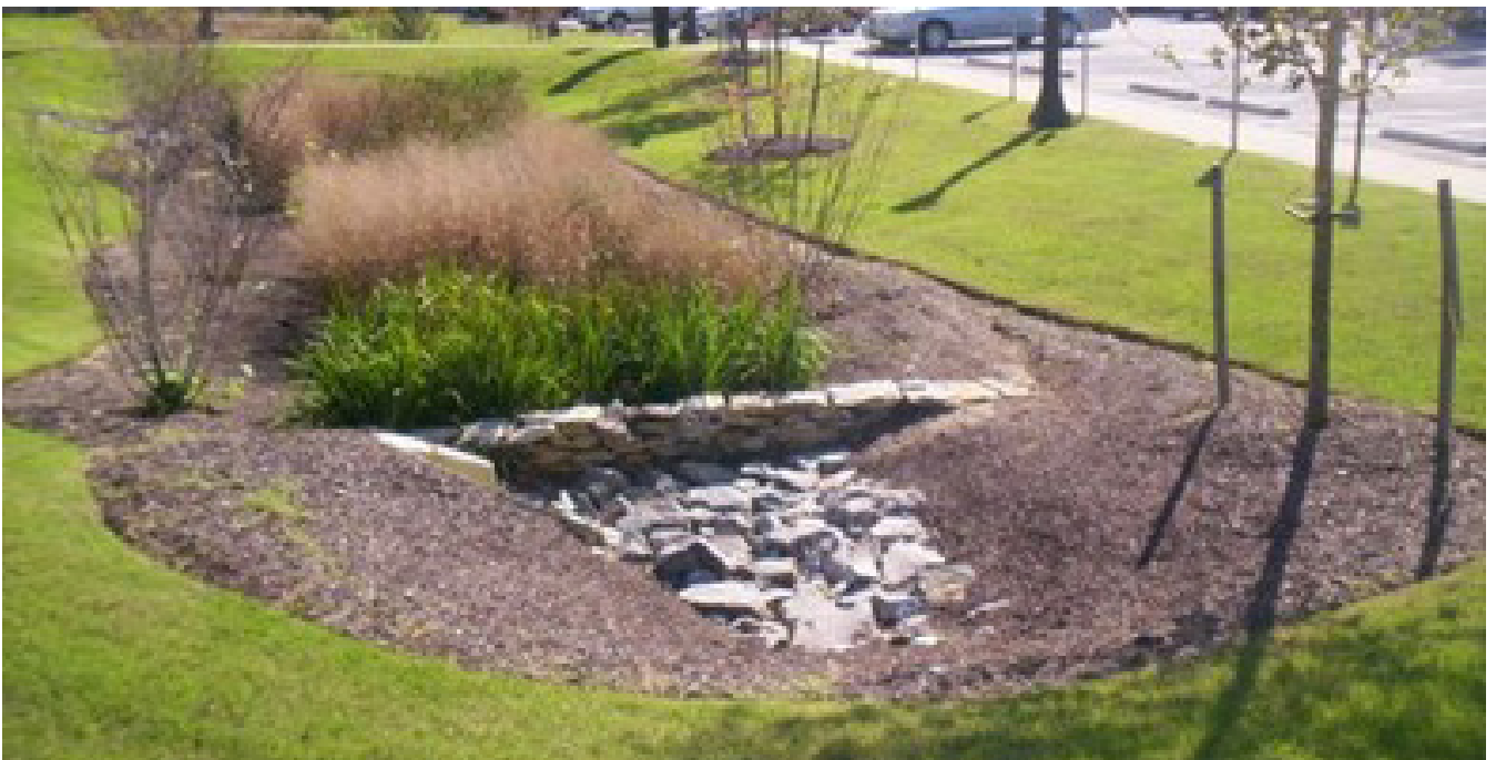
Figur 18 Permeabel barriere i regnbed. (Foto: EPA, USA)
