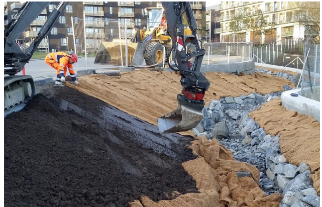
Figur 9.15 Bilde fra Hovinbekken hvor erosjonsmatter har blitt benyttet for å stabilisere sideskråningen i en etableringsfase. (Foto: Yvona Holbein, Oslo kommune)
