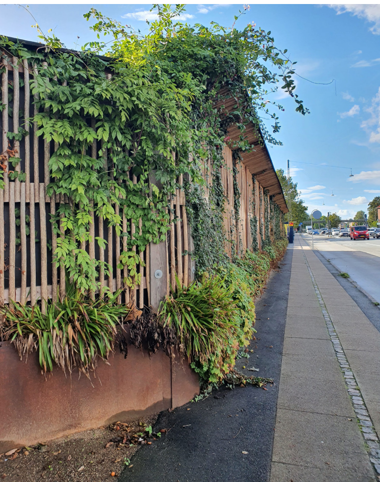
Figur 5.5 Grønn «Klimaskjermer» satt opp langs Folehaven, en hovedinnsfartsvei til København. Støyskjermer håndterer takvann fra boligblokken bak skjermen via fordampning fra skjermens sider. Samtidig skjermer bebyggelsen mot støy/støv fra gaten og skaper et nytt grønt byrom. Vannet transporteres fra tak til skjerm via hevert-funksjon (trykkhøyde fra tak). Utviklet av Københavns Universitet i samarbeid med blant annet «Teknologisk Institut» i Danmark. (Foto: Yvona Holbein, Oslo kommune)
