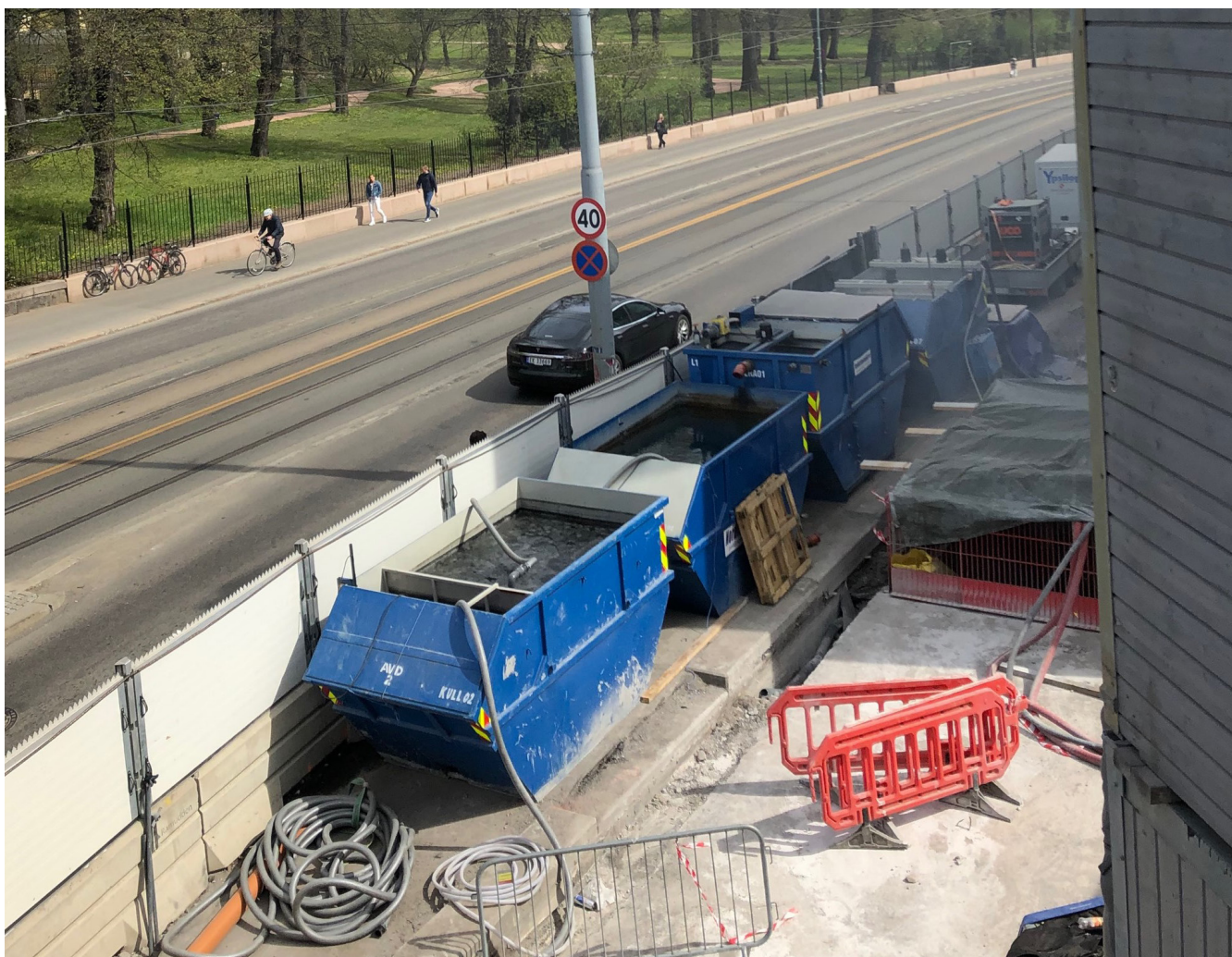
Benyttet renseløsning for forurenset overvann fra anleggsvirksomhet i Henrik Ibsens vei 48, Oslo. (Foto: Sander Sveinsson Hartmann, Oslo kommune)
