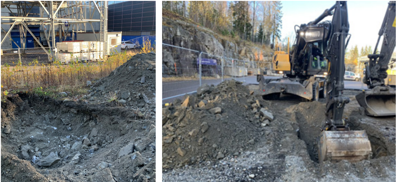
Figur 9 Grunnundersøkelse, sjaktning med gravemaskin i fyllmasser med fjell i bunn. (Foto: M. Tvedten, Asplan Viak)
