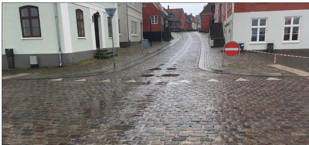
Figur 3. V-formet flomvei gjennom den eldre bydelen i Middelfart (slide fra Bjarne Rasmussen)
