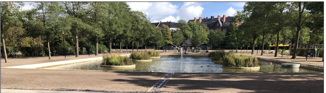
Figur 11. Enghaveparken er blitt et 35 dekar stort overvannanlegg med multifunksjon: Rent hverdagsvann ledes inn i nedgravde magasin under rosehaven (øverste bilde). Dette vannet kan brukes til vanning og i fontenen i dammen (nederste bilde). Ved mer nedbør fylles hockeybanen, deretter overflata på rosehagen. Ved skybrudd kan hele parken oversvømmes. Da vil porter automatisk stenge åpningene i betongveggen som omkranser anlegget og 22.600 m 3 overvann kan lagres (foto Bent Braskerud og Yvona Holbein).
