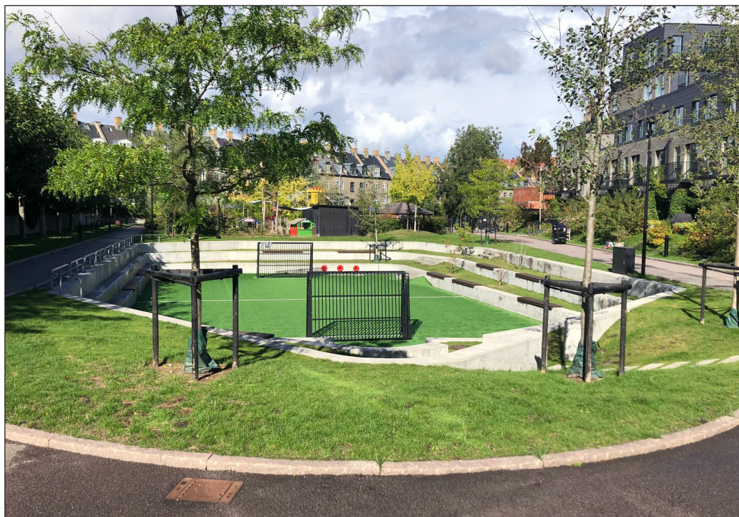
Figur 9. Nedgravd ballbinge i «Carlsberg byen» i København, innbyr til spill, avslapning i sola og tilbakeholding av mye vann under styrtregn. Foto: Bent Braskerud.
