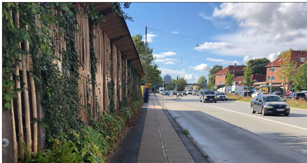
Figur 5. Klimaskjermen ble anlagt 2019 for å håndtere 5-årsregn hendelsen. Anlegget blir evaluert. Foreløpige tall viser at den håndterer ca. 14 mm/d (dvs. intensiteter tilsvarende 95% av årsnedbøren). I tillegg er det lagt til rette for infiltrasjon. Støy fra veien reduseres med 10 dB (foto Bent Braskerud).
